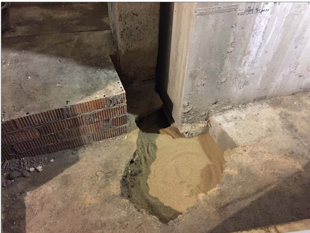
Foto 14. Detall del emplaçament del mur UE 06 un cop reblert amb malla de geotèxtil i capa de sorra per a la seva protecció
