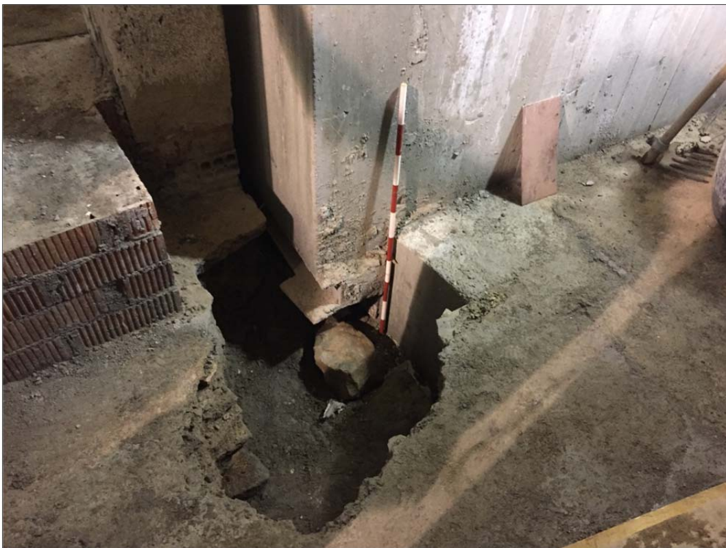
Foto 12. Detall del mur UE 06 i el forjat del fossat de l'ascensor.
