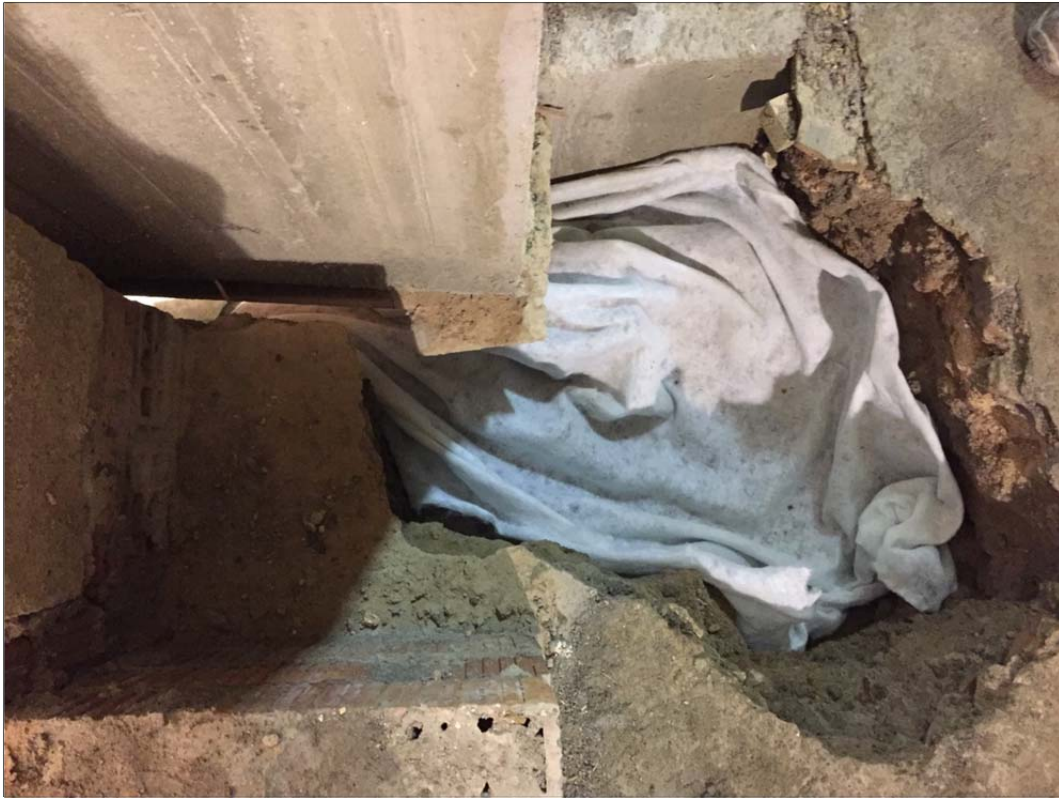
Foto 13. Detall del mur UE 06 amb el cobriment amb malla de geotèxtil
