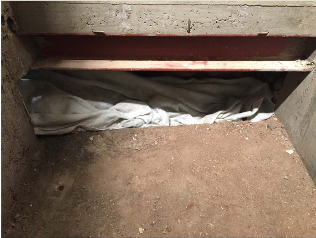
Foto 11. Detall del mur UE 06 amb la malla geotèxtil que el protegeix
